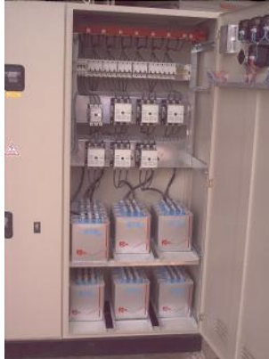
Resim 1.3: Orta büyüklükteki bir sanayi işletmesinde bulunan kompanzasyon panosu
