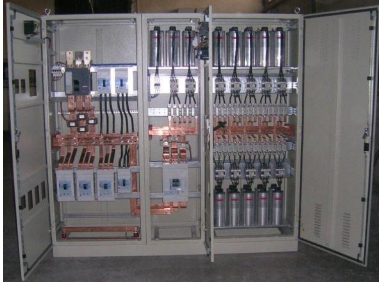
Resim 1.10: Orta büyüklükteki bir tesisin alıcılarının kompanze edildiği merkezi kompanzasyon panosu
